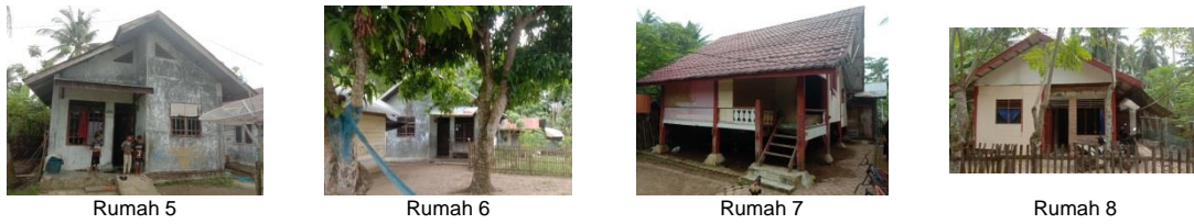
Gambar 1. Rumah Bantuan Tsunami di Gampong Kuala Meuraksa
