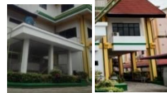
Kolom bagian tampak belakang
